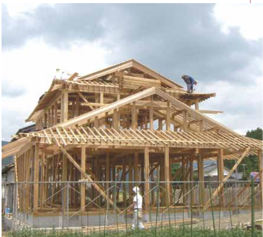
木造住宅の建築現場
