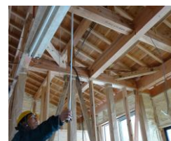
横架材の確認
