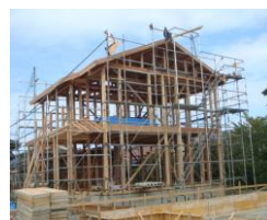
新築住宅の建前
