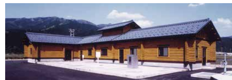
浄化施設（屋根越前瓦）
